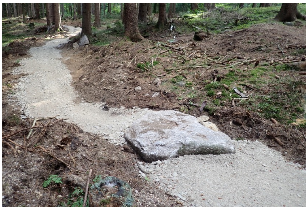
Wystający kamień z nawierzchni ścieżki (sekcja nr 48)
