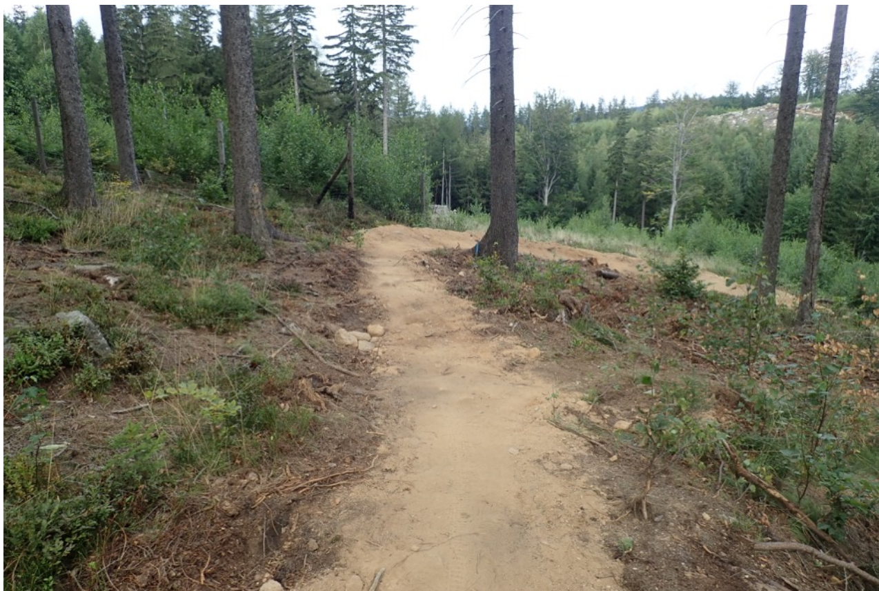
Brak odwróceń nachylenia przed profilowanym zakrętem (sekcja nr 50)
