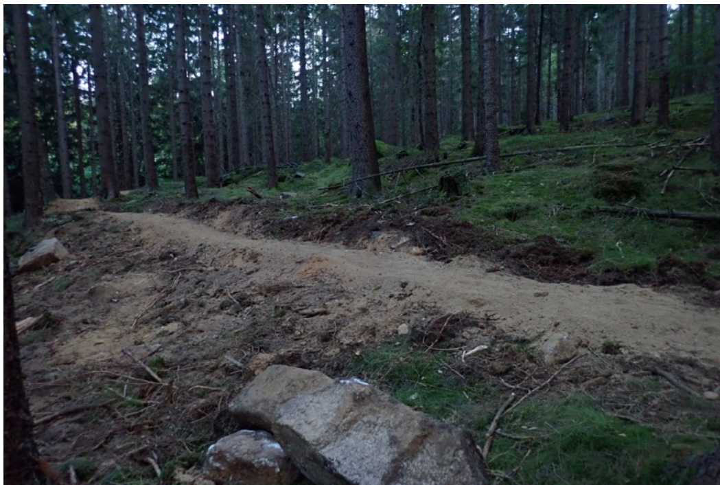
Brak odwróceń nachylenia (sekcja nr 39)
