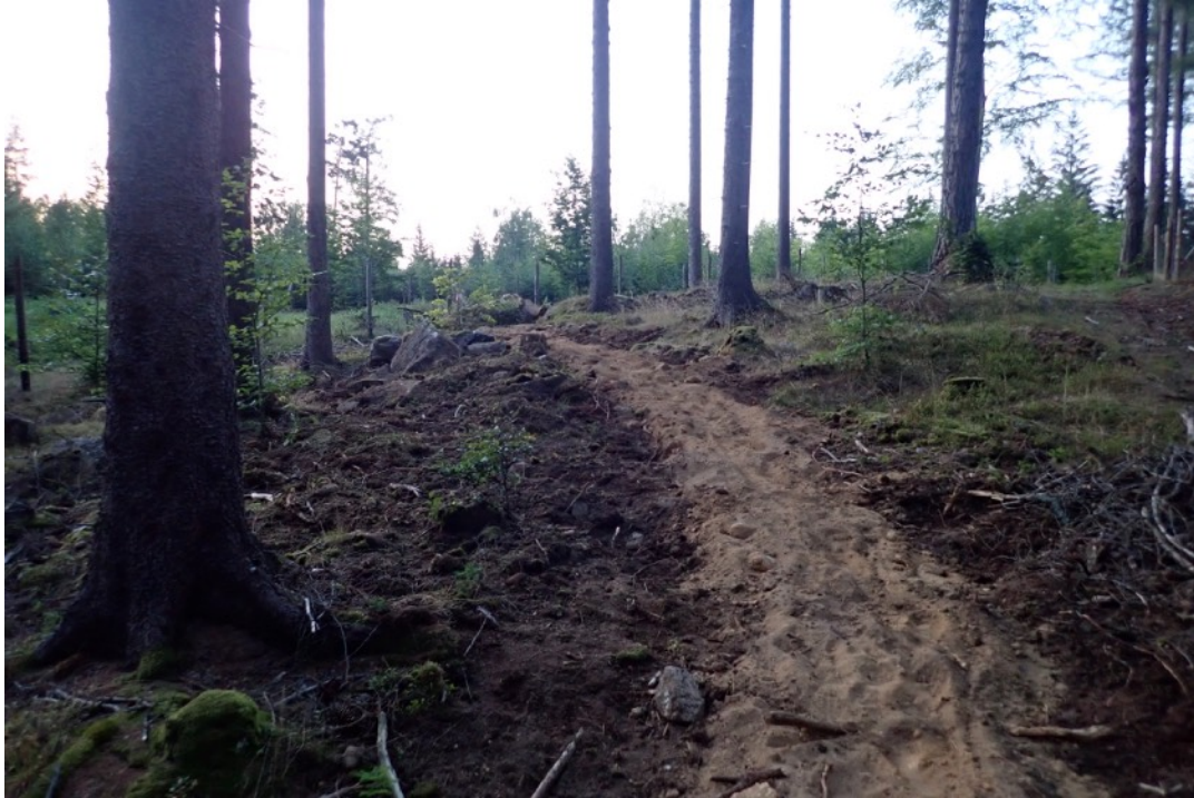
Podbudowa wykonana ze zmieszanej warstwy organicznej i mineralnej (sekcja nr 39)
