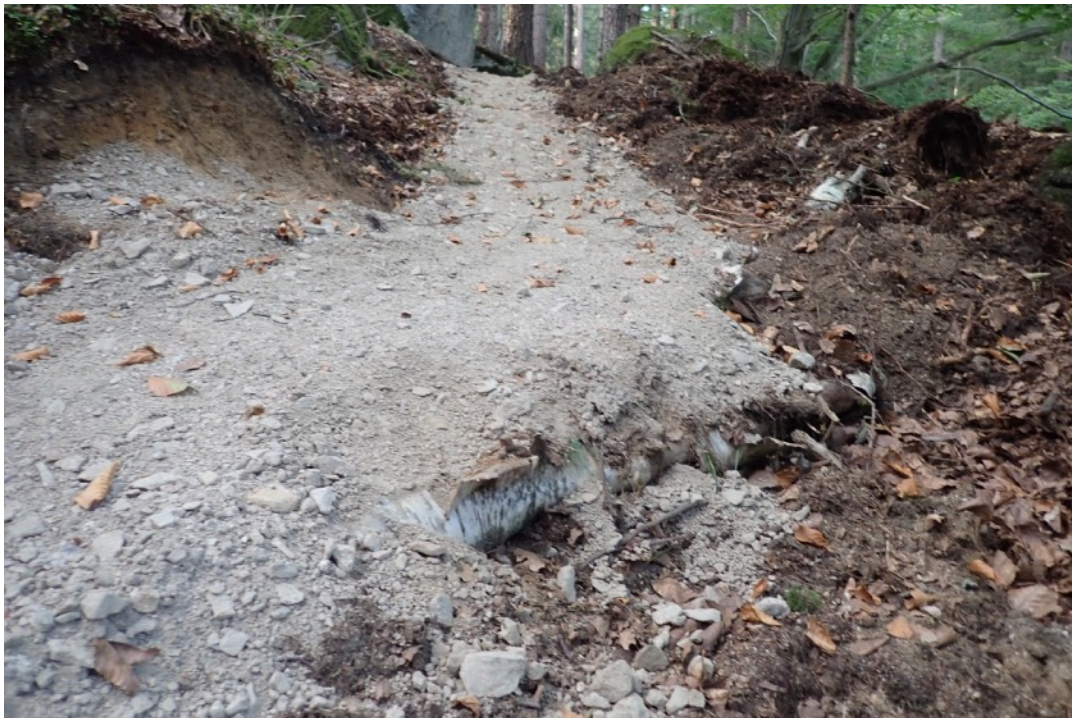
Nawierzchnia oparta na brzozowych belkach zdjęcie (sekcja nr 53)
