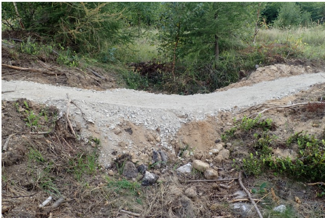
Zasypywanie i wyrównywanie naturalnych zagłębień (sekcja 50)
