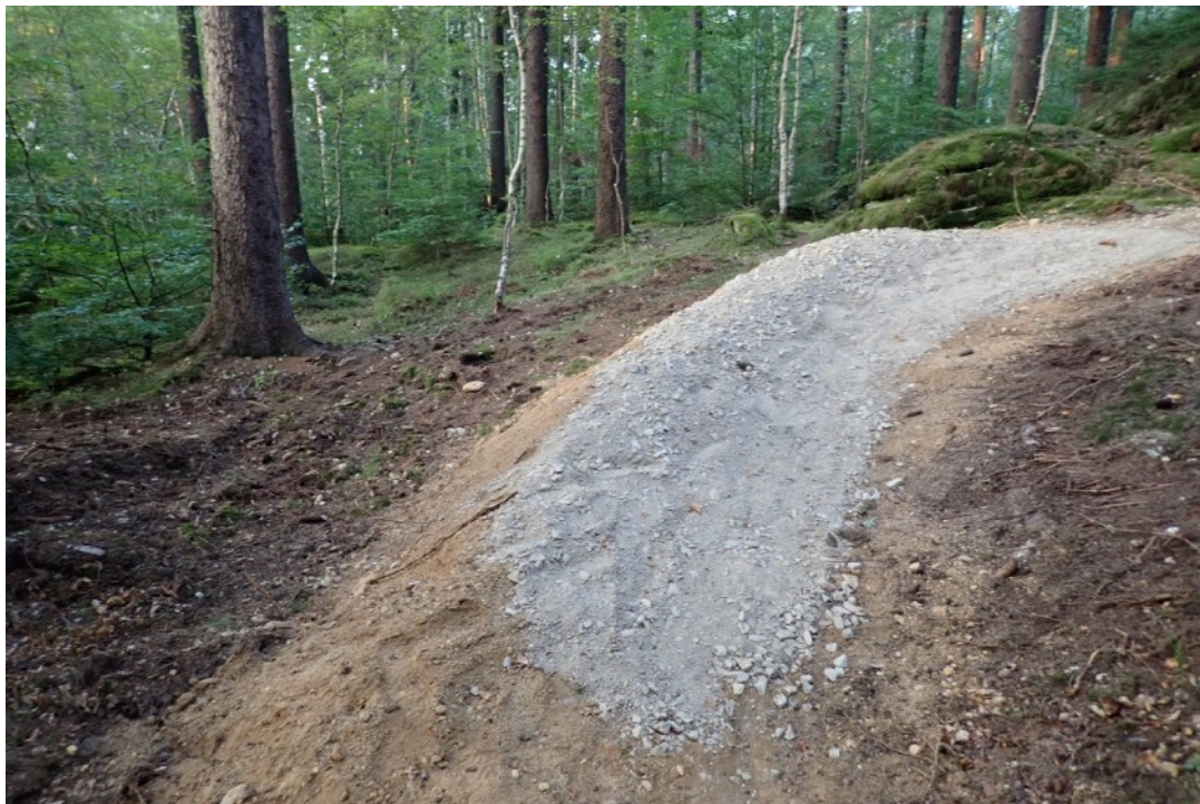
Za krótki profil zakrętu (sekcja nr 43)
