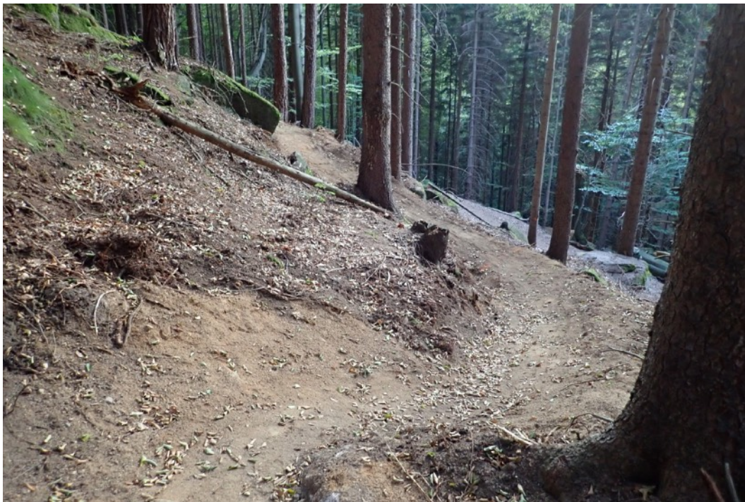
Ciasne opadające zakręty które będą zatrzymywać wodę (sekcja nr 43)
