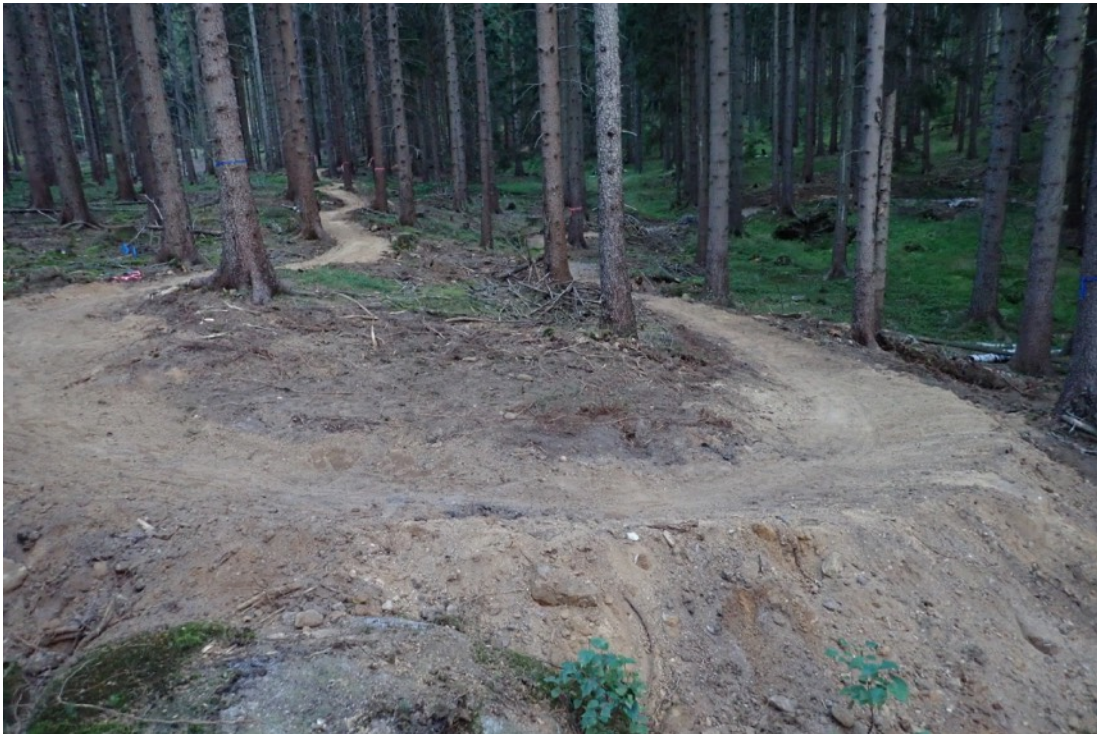
Nieprawidłowy kształt profilu (sekcja nr 38)
