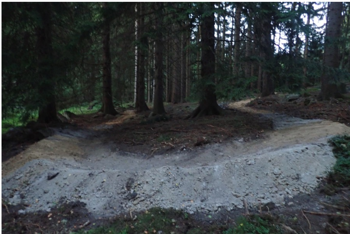
Brak zagęszczenia nasypu (sekcja nr 39)
