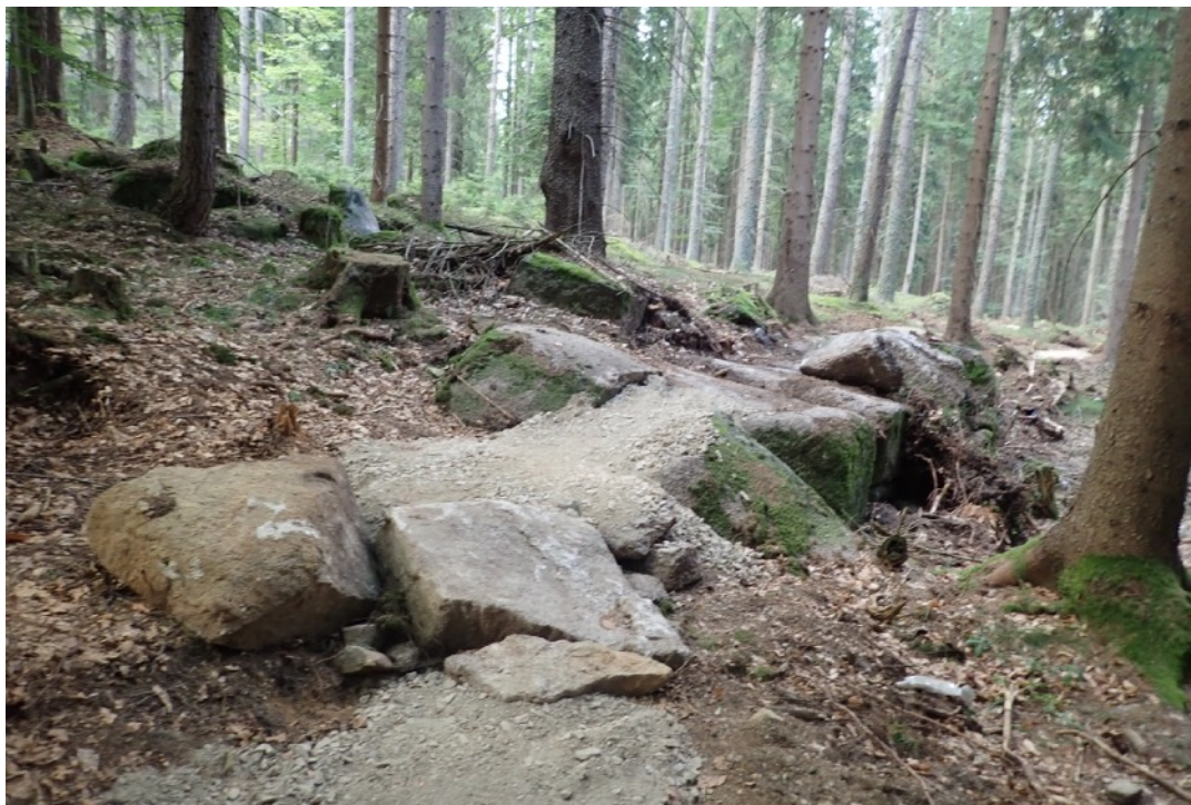
Za trudny odcinek na trasę lekko wymagającą, nierówno ułożone kamienie (sekcja nr 48)
