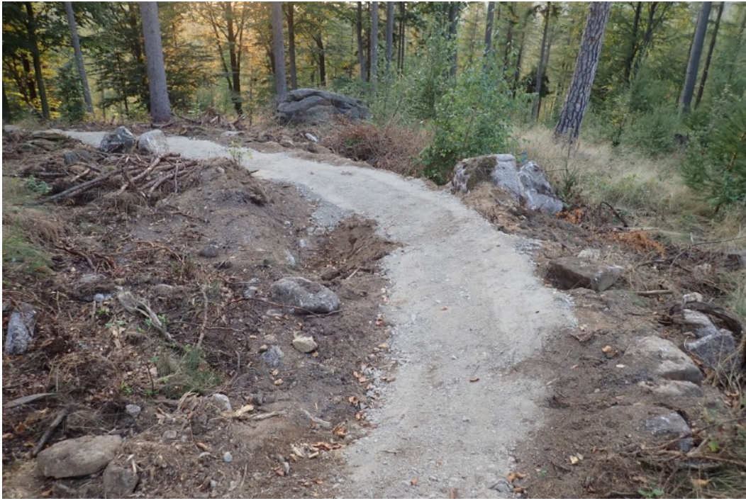
Za niski nasyp zakrętu (sekcja nr 43)
