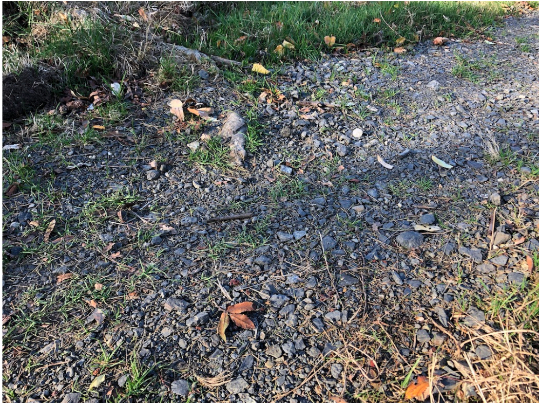
Wyrastająca trawa ze świeżo zbudowanej nawierzchni.
