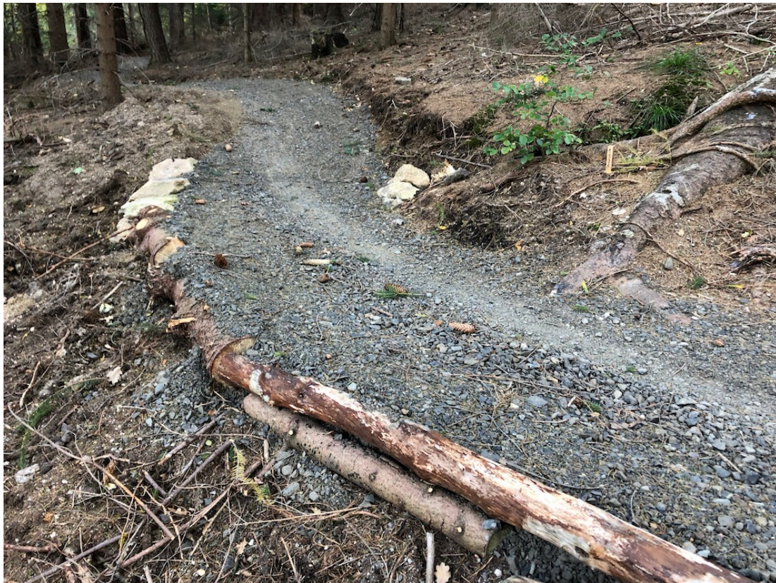
Używanie materiałów organicznych jako elementów konstrukcyjnych trasy.
