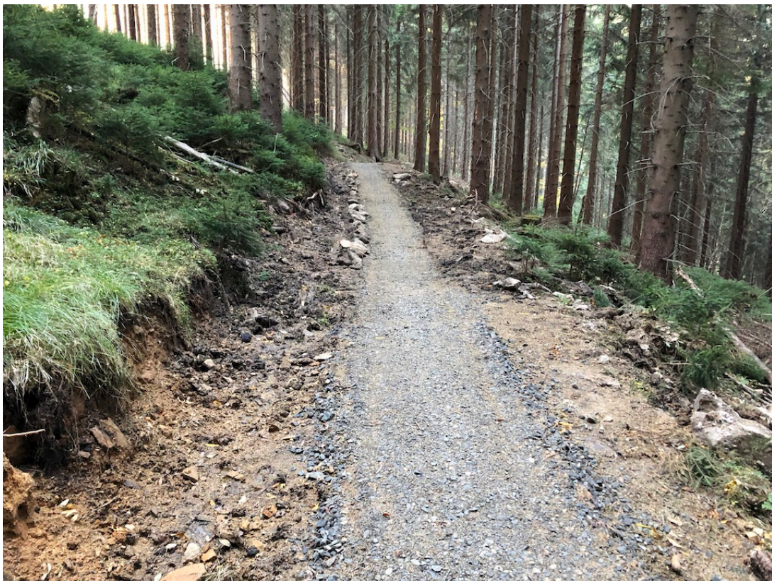
Brak seskarpowania stoku nad górną krawędzią ścieżki. Za szeroka podbudowa trasy poszerzająca optycznie ścieżkę. Brak odwróceń nachylenia.
